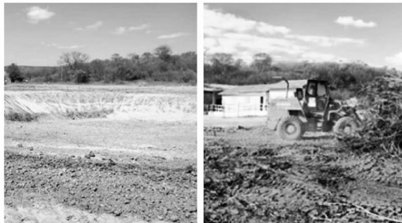
Figura 4. Limpeza e início da perfuração da área da barragem
