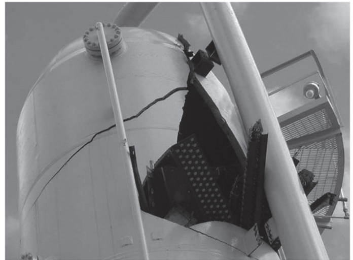
Figura 2. Ilustração de um vaso de pressão em que uma pressão acima do nominal provocou seu colapso, mesmo considerando os coeficientes de segurança de projeto, provavelmente por ter altas tensões residuais após fabricação
