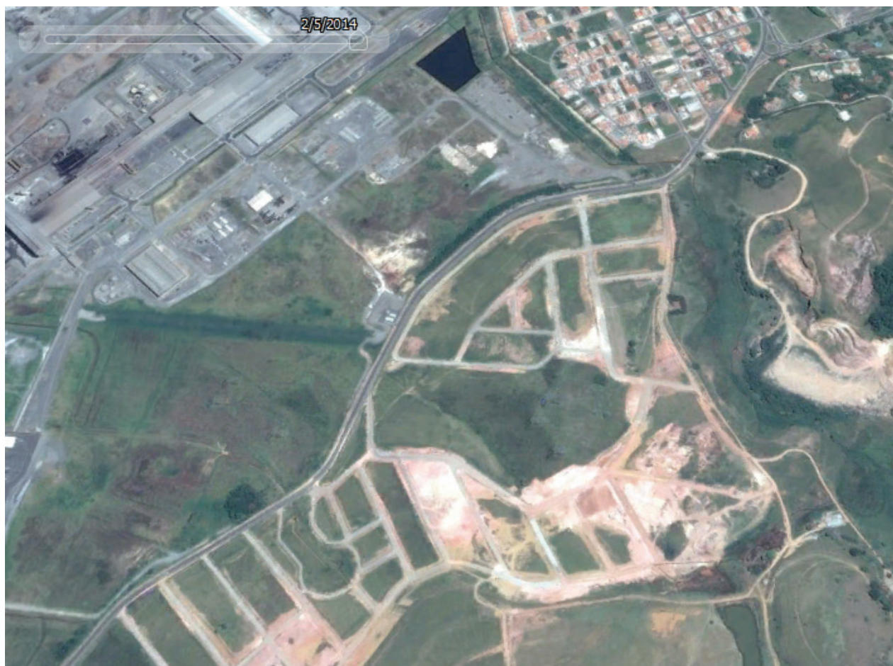
Figura 3 - Fase de terraplanagem do empreendimento “A”
