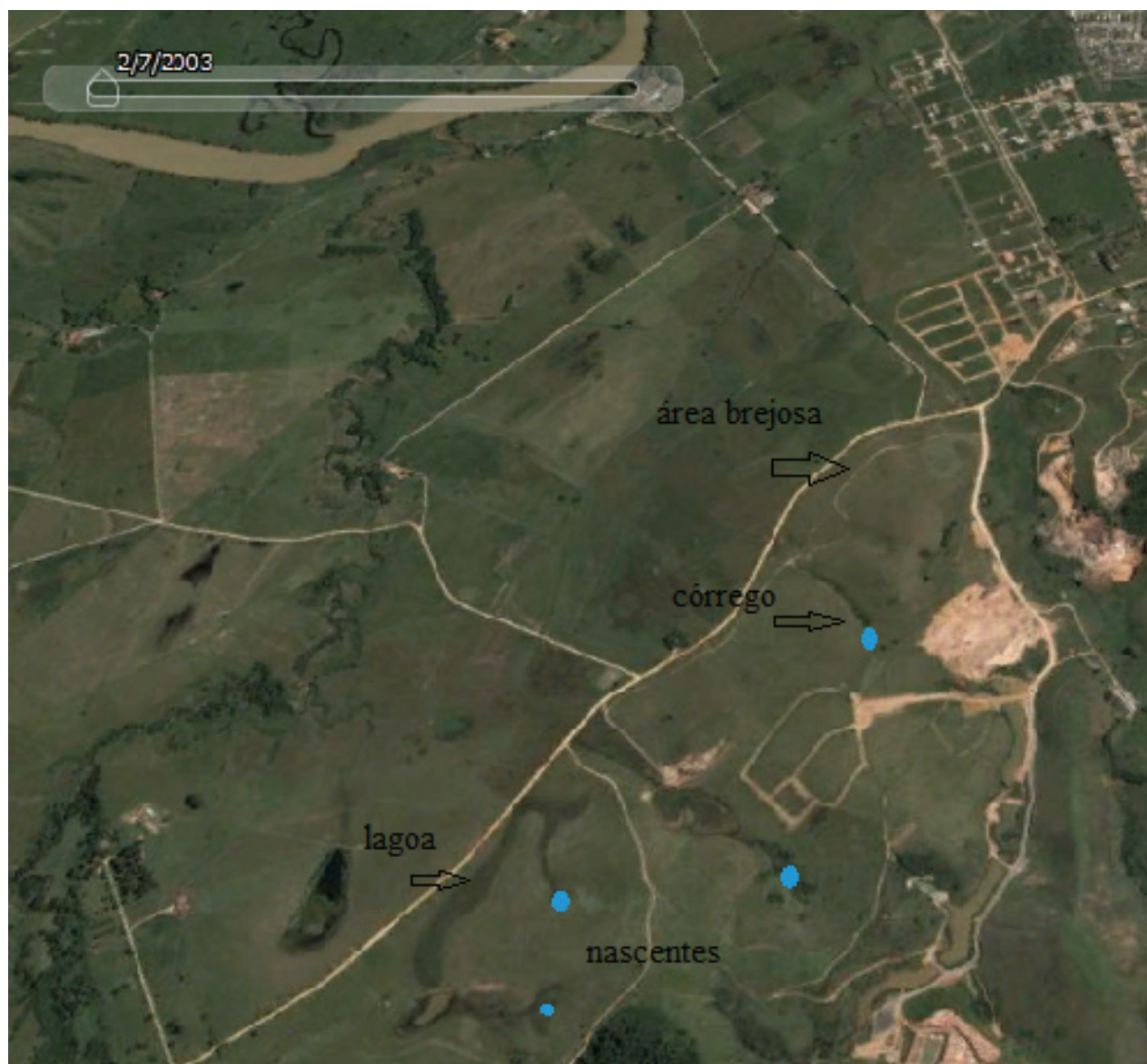
Figura 2 - Empreendimento “A” antes da fase de terraplanagem.
