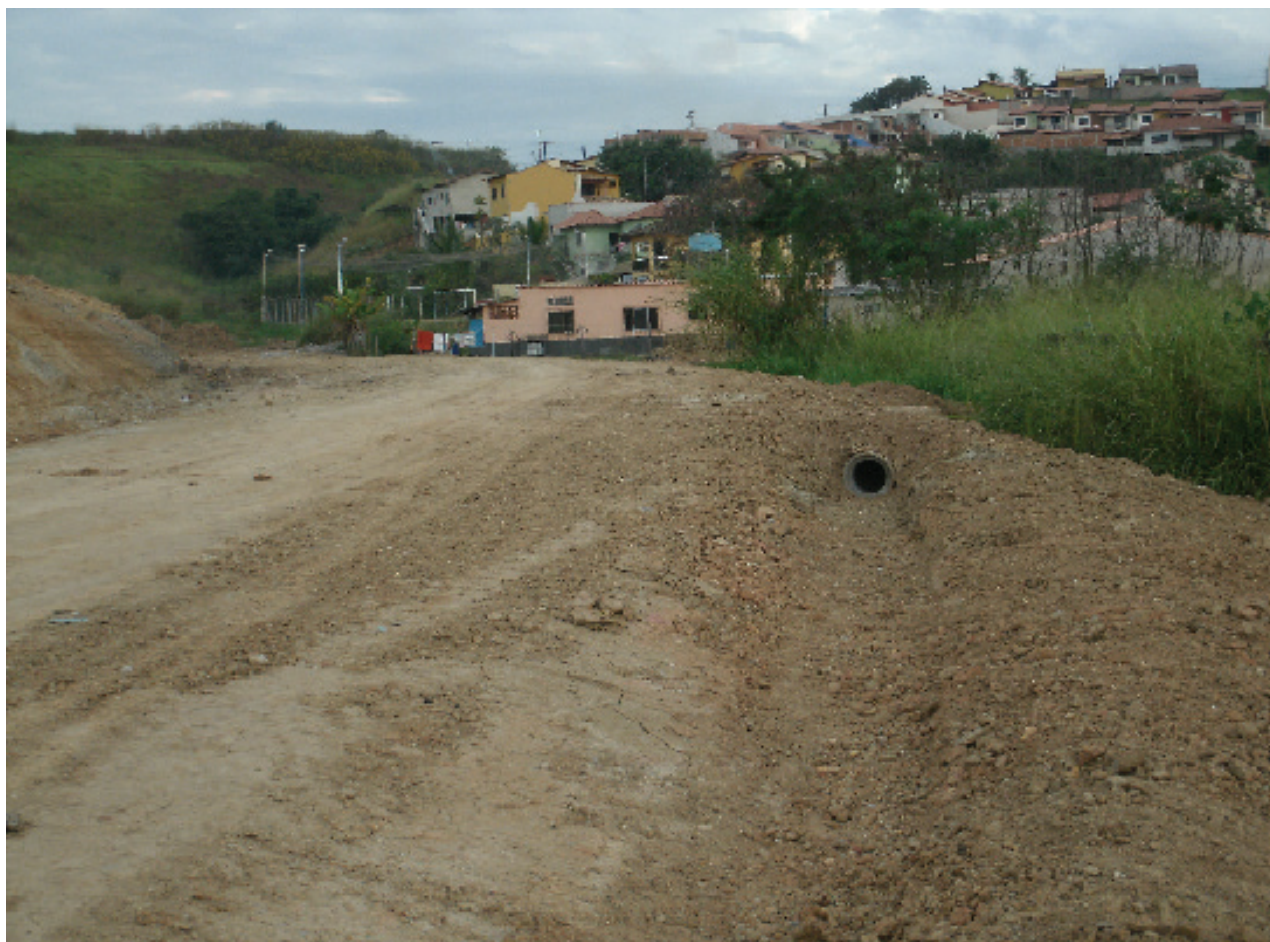
Figura 6 - Canalização do corpo hídrico.
