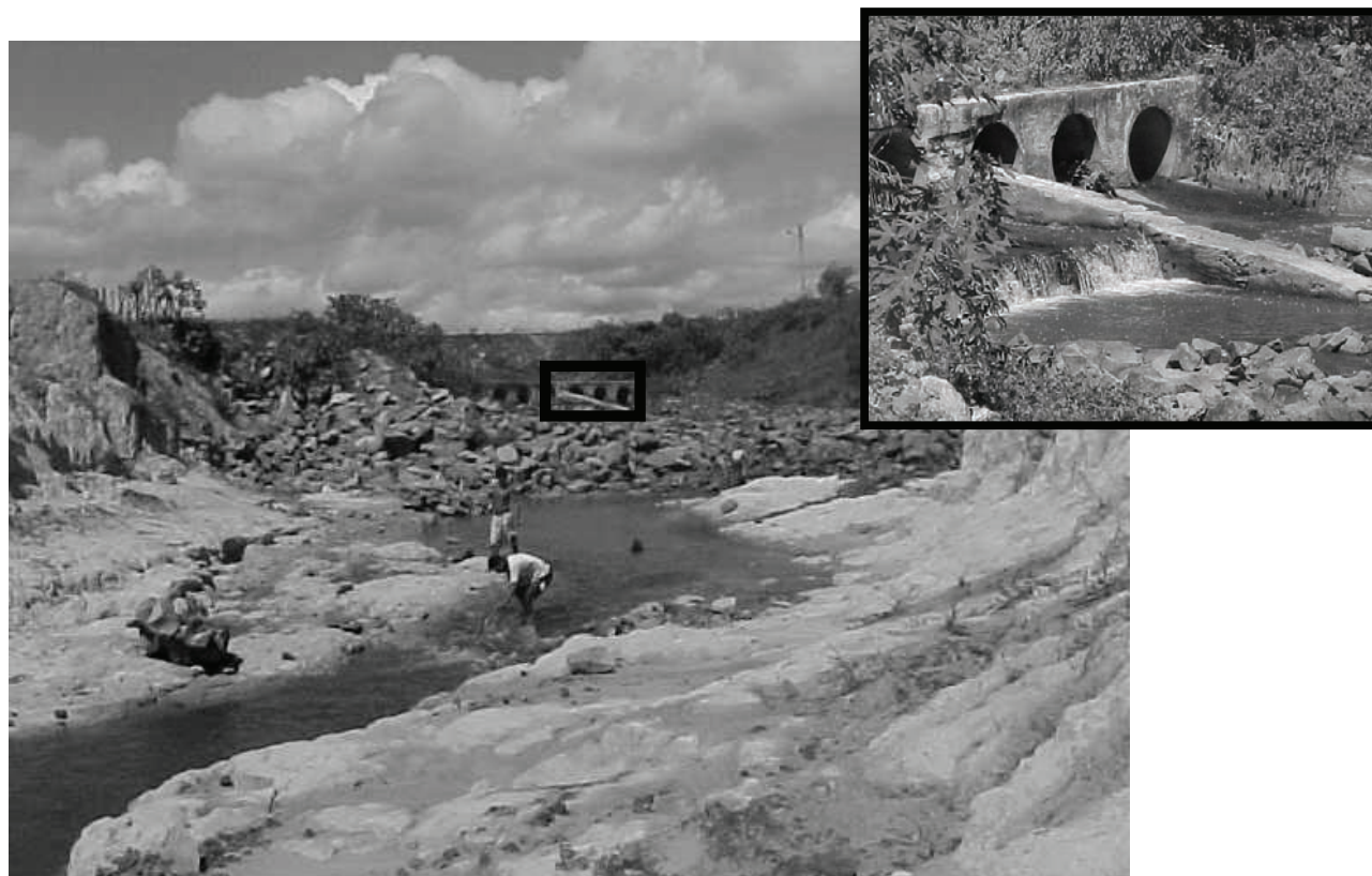
FIGURA 2: Vertedouro construído em 2003 para regularização do volume da Lagoa do Catú para fins de abastecimento e controle de inundações.
