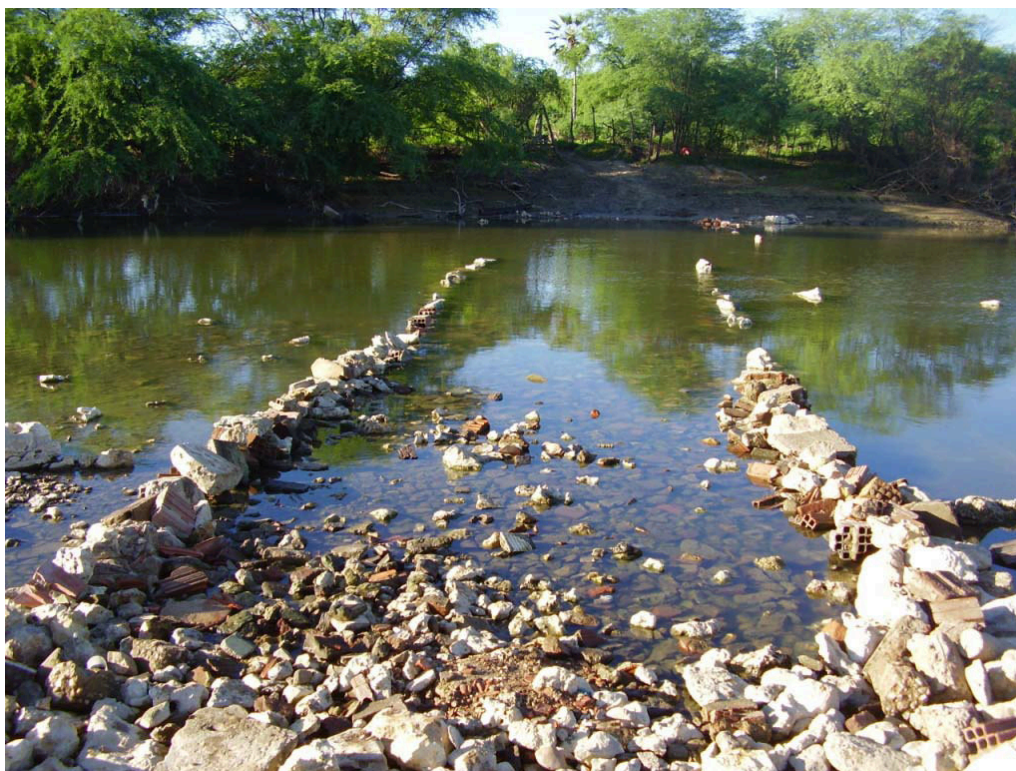
FIGURA 6. Construção de pontes artesanais no leito do rio Apodi-Mossoró para a passagem de pessoas e veículos. Maio de 2008. Foto do autor.
