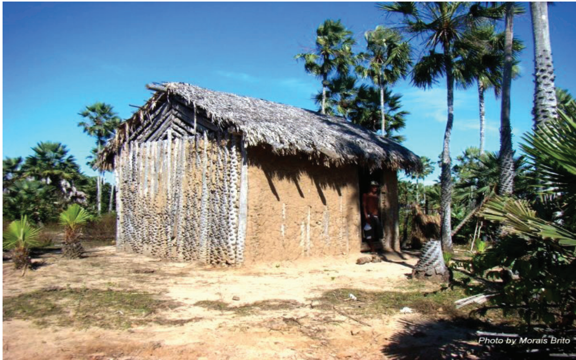
Figura 3. Casa de taipa com cobertura de palha, Ilha Grande de Santa Isabel.
