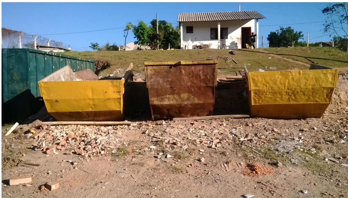
Figura 3. Caçambas para recebimento de RCC, resíduos volumosos e podas de árvores localizadas no interior de um Ecoponto em Limeira/SP.
