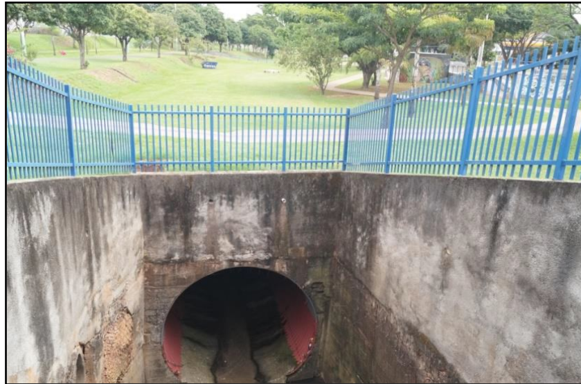
Figura 2 - Parque do Povo - Canalização do trecho inicial Córrego do Veado
