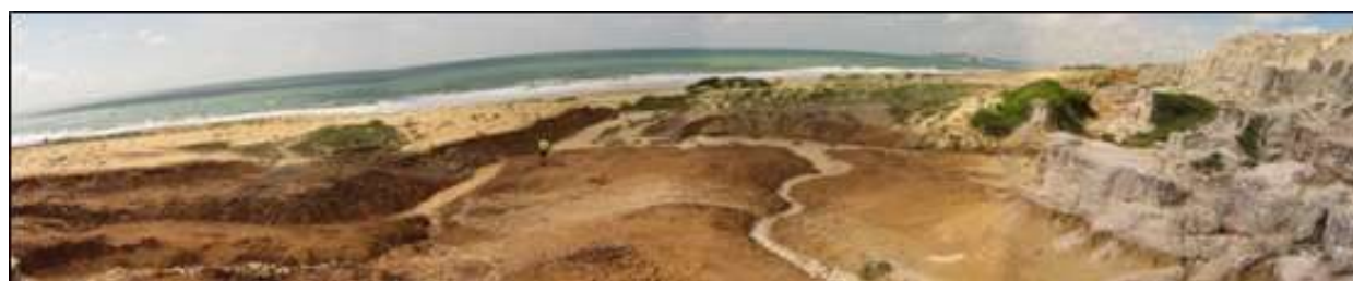
Figura 06 – Falésias inativas (canto direito da imagem) e depósitos de talude com marcas dos cursos d'água formados em épocas de chuvas (atual fator erosivo preponderante).
