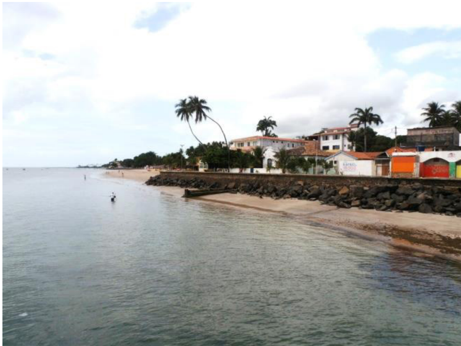
Figura 2 - Construções fixas e muro de p
