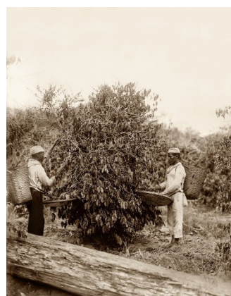
Imagem de homens escravizados trabalhando no cafezal
