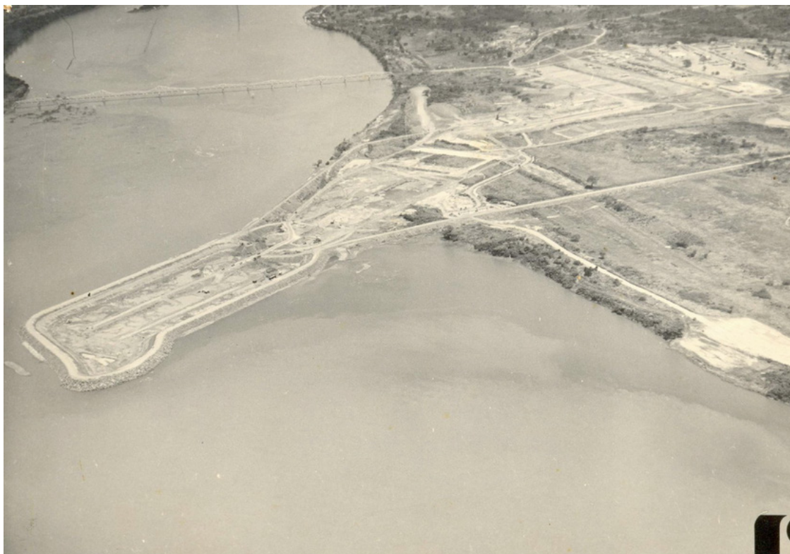
Figura 2: Ensecadeira e canteiro de obras em Jupuíá (1961).
