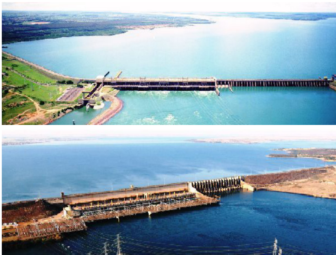
Figura 1: Complexo Hidrelétrico Urubupungá
