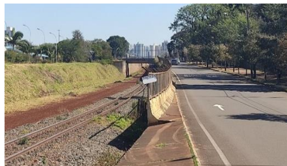
Figura 2 – Infraestrutura ferroviária em Maringá/PR. Fonte: Autores (2021).
