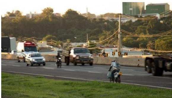
Figura 1 – Trecho da rodovia PR-445 em Londrina/PR. Fonte: Autores (2020).
